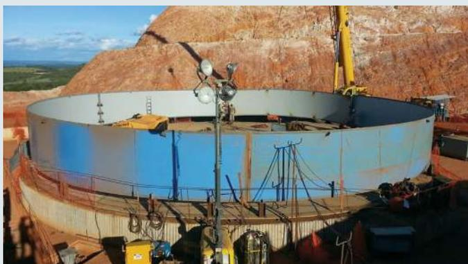
À esq., montagem do tanque em Conceição do Mato Dentro/MG e à dir., montagem em São João da Barra/RJ
