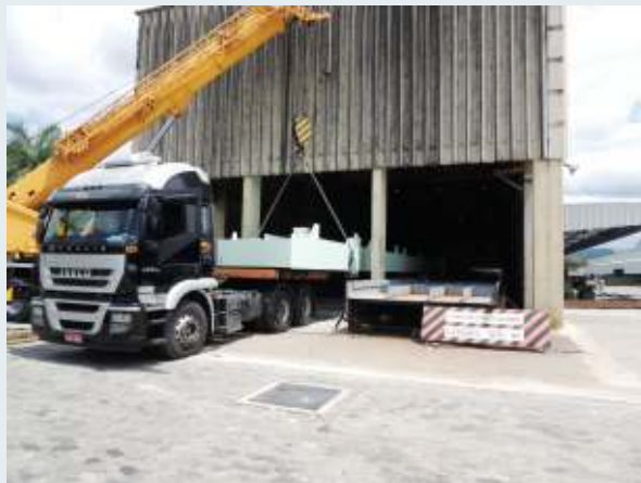
A viga de rolamento de grande dimensão exigiu cuidados especiais da equipe de logística
