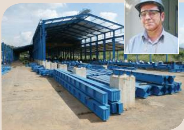
Dermeval Messias e a ampliação da Emalto Estruturas Metálicas
